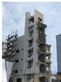
能登地震の被害を受け、取り壊し中の和倉温泉旅館
